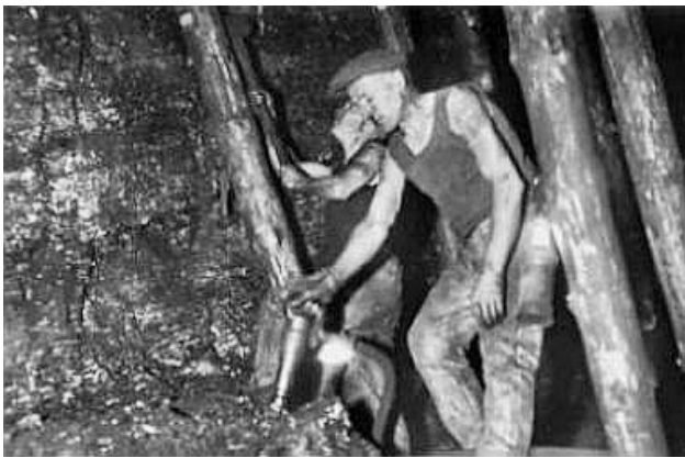
Ein Kohlenhauer bei der Arbeit. Hier wurde der Streb noch mit Einzelstempel aus Holz abgesichert
